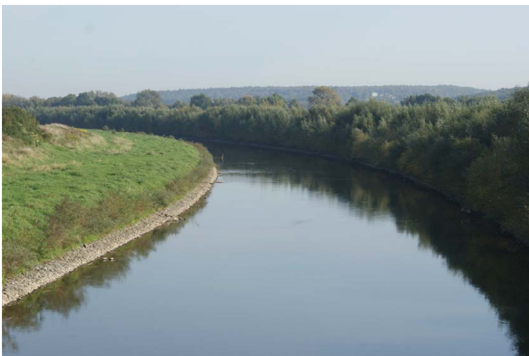
Fot 10 Fragment trasy istniejącego Kanału Ulgi w rejonie zapory czołowej zbiornika Racibórz Dolny (polder)
