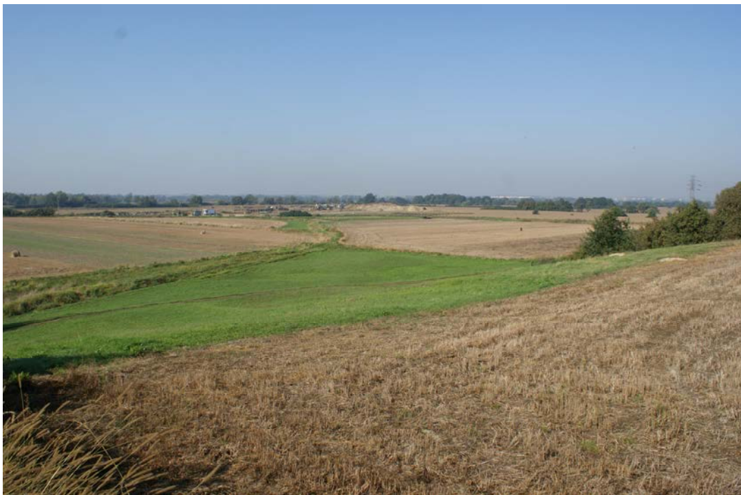
Fot 2 Widok od strony południowo-wschodniej na teren lokalizacji zapory czołowej i tereny aktualnej eksploatacji kruszyw
