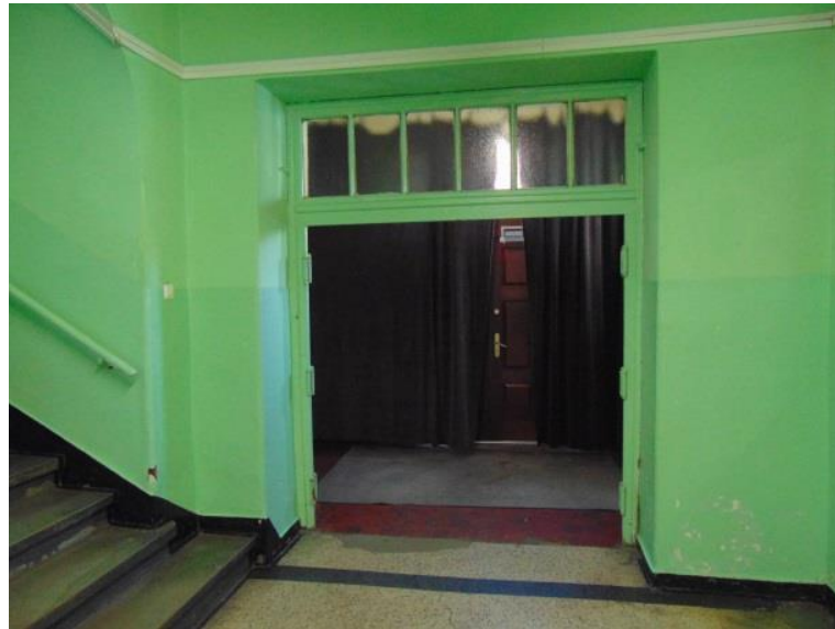
Stan „przed realizacją”
