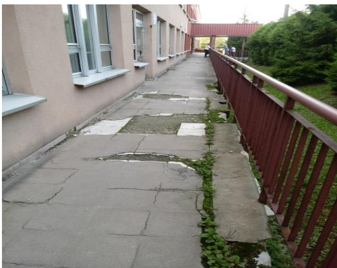
Stan „przed realizacją”
