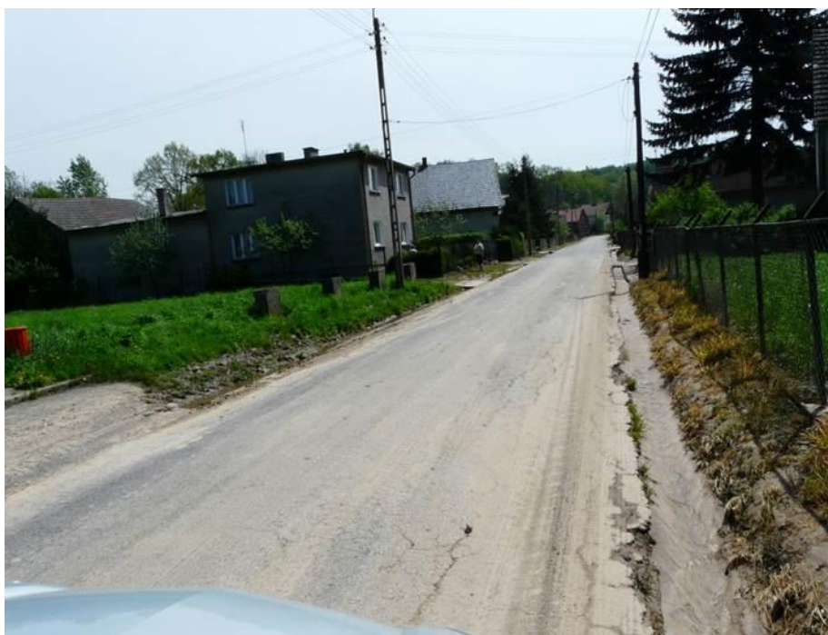
Stan „przed realizacją”
